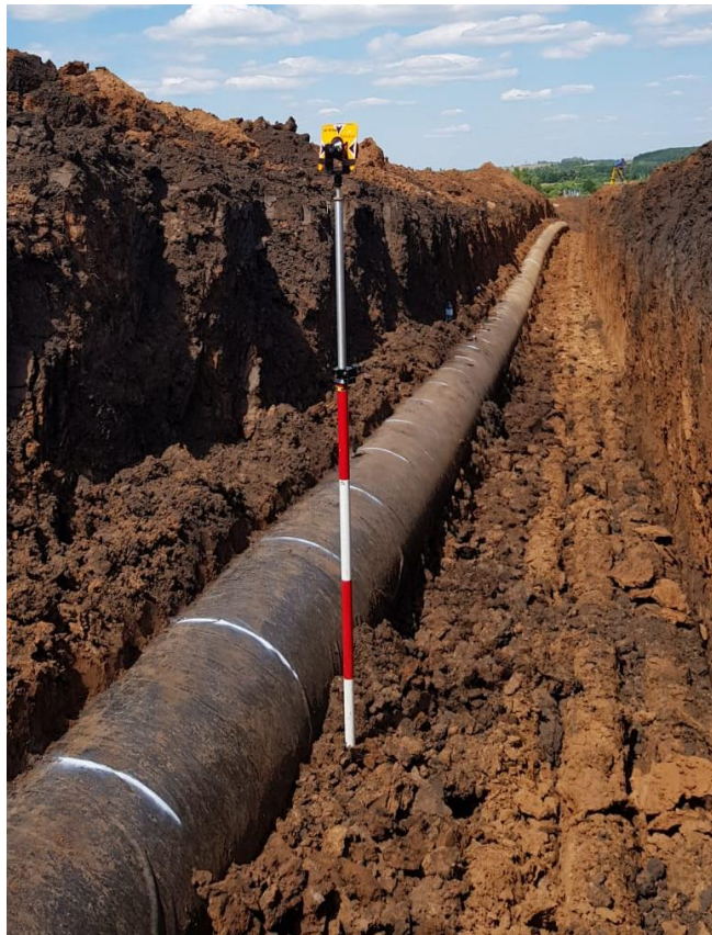
Рис. 5. Участок газопровода-отвода к ГРС Карманово DN700
