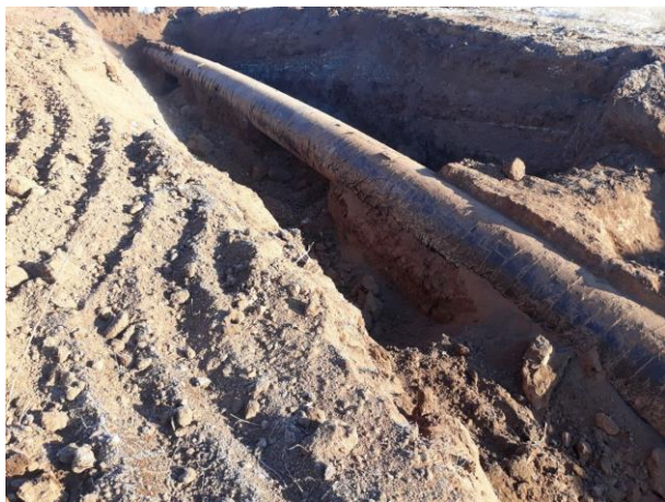
Рис. 1. Упругопластический изгиб газопровода
