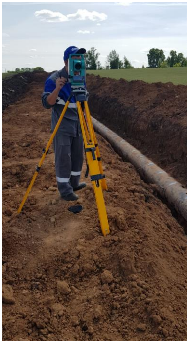
Рис. 6. Геодезическая съемка участка газопровода-отвода к ГРС Карманово DN700
